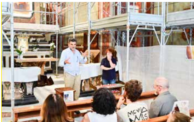
L'architetto Carlo Mariani illustra i lavori in corso
