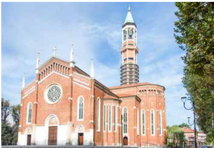
Le operazioni di smontaggio dei ponteggi del campanile
