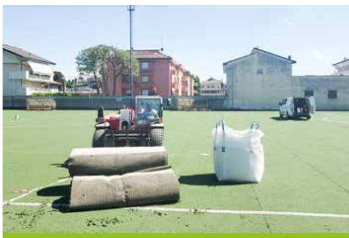
I lavori per il rifacimento del campo di calcio
